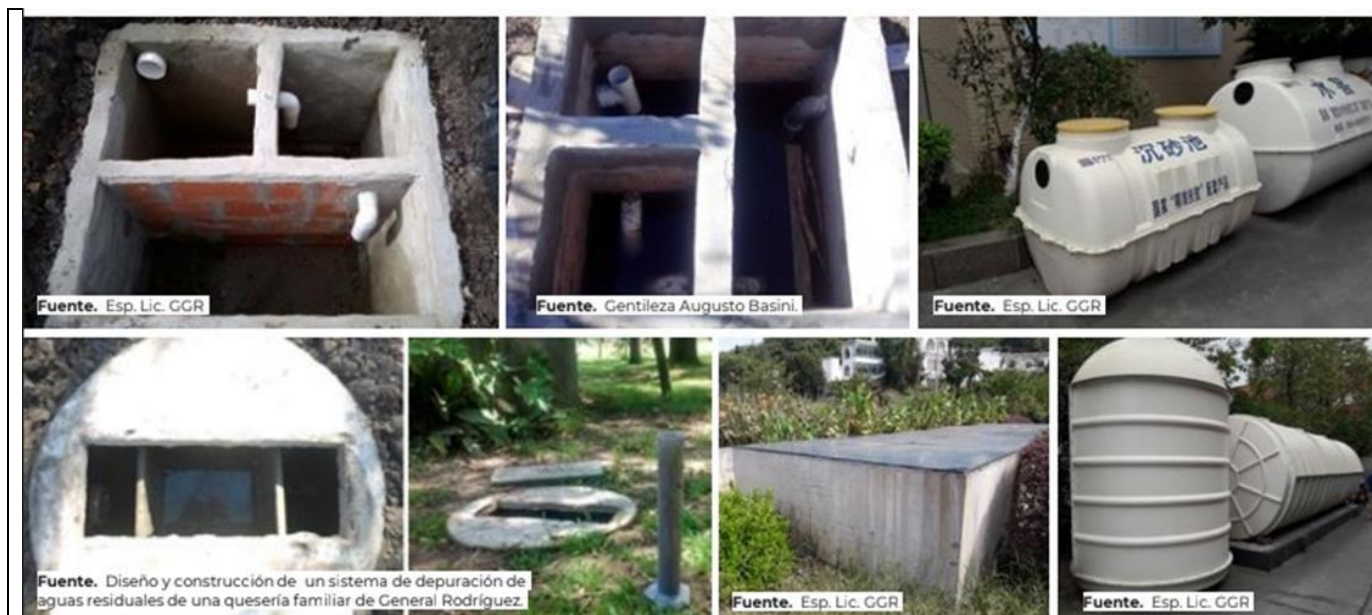
Imagen 3 - Cámara Séptica – Distintas variantes - Fuente: INTI, Gustavo Ruhi
